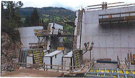
Abbildung 1: Rostwangen während der Bauphase (Diebsbach)
