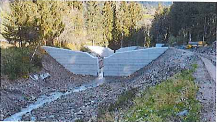
Abbildung 3: Adaptiertes Geschieberückhaltebecken am Lahmbach
