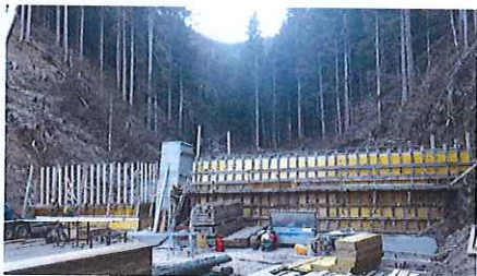
Abbildung 4: Schalungsarbeiten an der Geschieberückhaltesperre am Lahmbach
