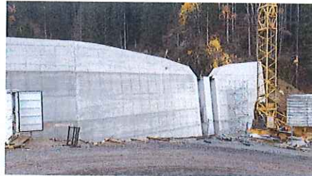
Abbildung 2: Fertiggestellte Geschieberückhaltesperre am Diebsbach
