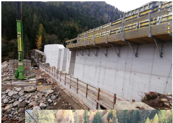
Abbildung 2: Murbrecher Mittellauf (Zleinitzbach)
