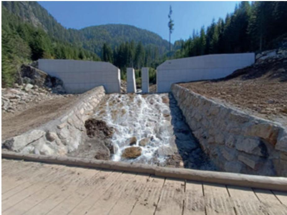
Abbildung 2: Murbrecher mit Vorfeldsicherung Mittellauf (Zleinitzbach)
