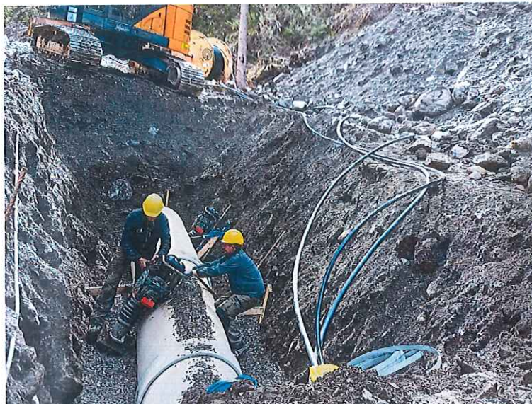
Foto: Verlegung Druckrohrleitung Durchmesser 900 mm
